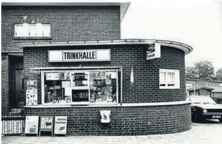
Strundener Straße 38, Köln-Dellbrück (1982)
